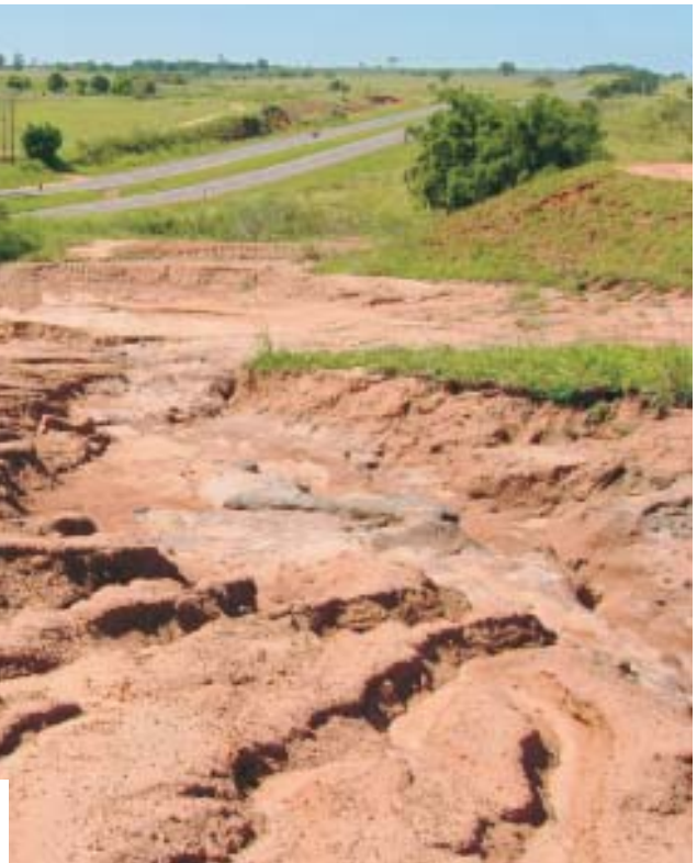
Figuras 14.50 e 14.51 – Processos erosivos induzidos pela concentração das águas das chuvas em um talude de corte e em uma área de terraplenagem sobre terrenos arenosos da Formação Marília (SP). Nos terrenos arenosos, deve-se evitar a execução de obras que envolvem escavações e terraplenagem durante os períodos chuvosos. Obras desse tipo devem ser de imediato dotadas de disciplinamento das águas das chuvas e de proteção contra a erosão.
