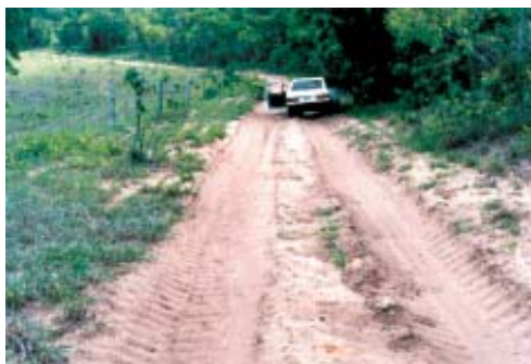
Figura 14.53 – Estradas não-pavimentadas sobre areiões são difíceis de serem trafegadas; a circulação dos carros aprofunda o leito, sujeitando-os a “atolarem” na areia inconsolidada (área de definição dos arenitos da Formação Botucatu, SP).
