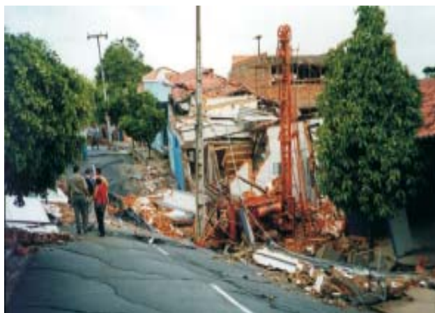
Figura 9.9 – Subsidiência do terreno na cidade de Teresina (PI).
