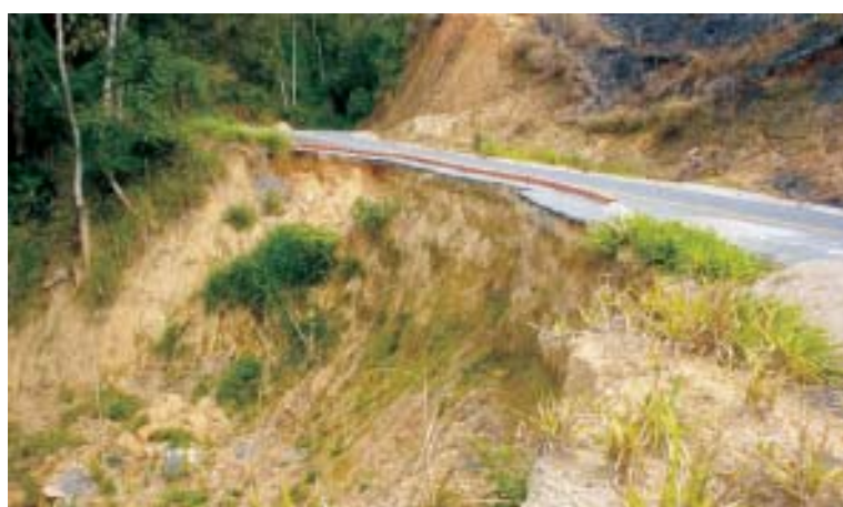
Figuras 14.154 e 14.155 – Processos erosivos decorrentes da exposição de solos residuais pouco evoluídos de granitos em talude de corte e utilizados na confecção de aterros (região do Vale do Ribeira, SP).
