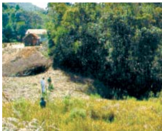
Figuras 14.118 e 14.119 – Moradia construída junto a dolinas, prática não recomendada, uma vez que o risco de afundamento em um local como este é alto (município de Almirante Tamandaré, PR).
