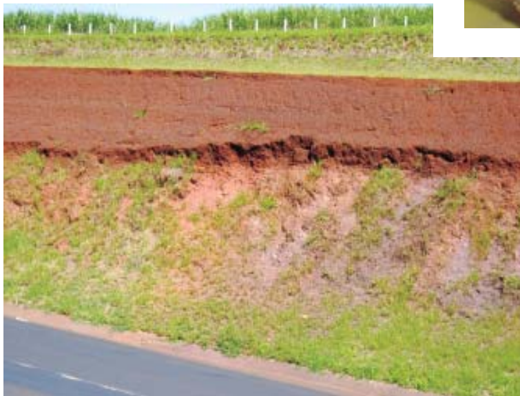
Figura 14.84 – Erosão diferencial em solo derivado de basalto. A parte inferior mais erosiva é sustentada por um solo pouco evoluído e portador de argilominerais expansivos – a variação dos estados de expansão e contração dos argilominerais expansivos faz com que o solo se desagregue em pequenas pastilhas que erodem como se fossem areias inconsolidadas. A parte superior, pouco erosiva, é sustentada por solo bem evoluído. Nesse caso, mantém boa estabilidade em taludes de corte (região de Fernandópolis, SP).
