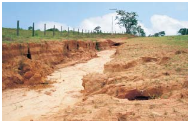
Figura 13.29 – Erosão desenvolvida a partir de desmatamento e falta de drenagens adequadas (município de Rio Branco, AC). Fotografia: Amilcar Adamy.
