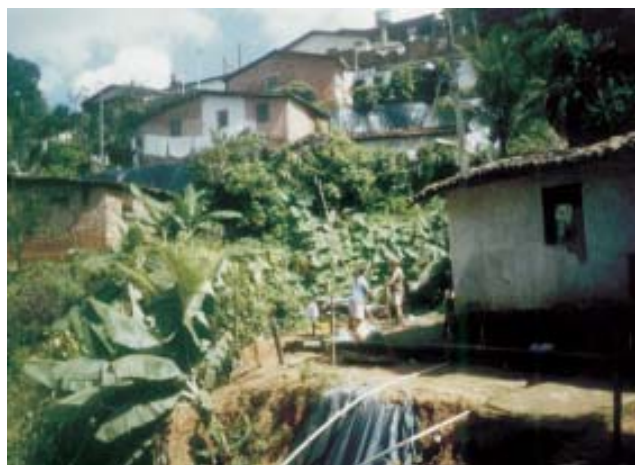
Figura 9.11 – Sequência de deslizamentos em encostas da Formação Barreiras (D6.1). Córrego da Andorinha, Camaragibe (PE).
