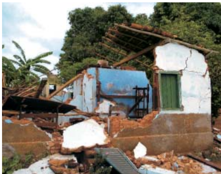
Figura 9.22 – Destruição causada por terremoto em Itacarambi (MG) (disponível em: http://www.estadao.com.br/cidades/not_cid93085,0.htm ).
