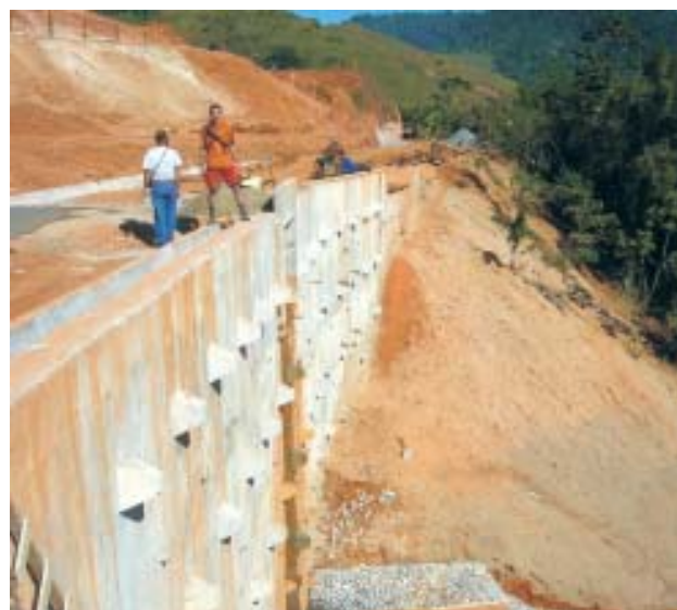
Figura 13.22 – Obra de contenção de encosta em área em que já havia ocorrido escorregamento em 2004 (Bairro Areal, Angra dos Reis, RJ). Fotografia: C. R. Silva.
