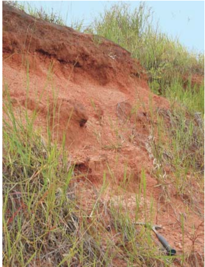
Figura 14.44 – Desestabilização em um talude de corte sustentado por sedimentos da Formação Santo Anastácio (SP).
