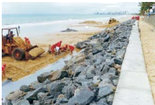
Figura 6.8 – Obra para contenção do avanço do mar na praia de Boa Viagem (Recife-PE).
