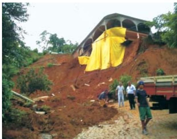
Figura 13.31 – Deslizamento em encostas, em janeiro de 2007 (Bairro Vilage, Nova Friburgo, RJ). Fotografia: Jorge Pimentel.
