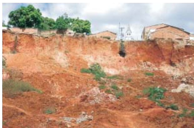
Figura 9.17 – Voçoroca em expansão, localizada na cidade de Quipapá (PE), que evoluiu após deslizamento da encosta.
