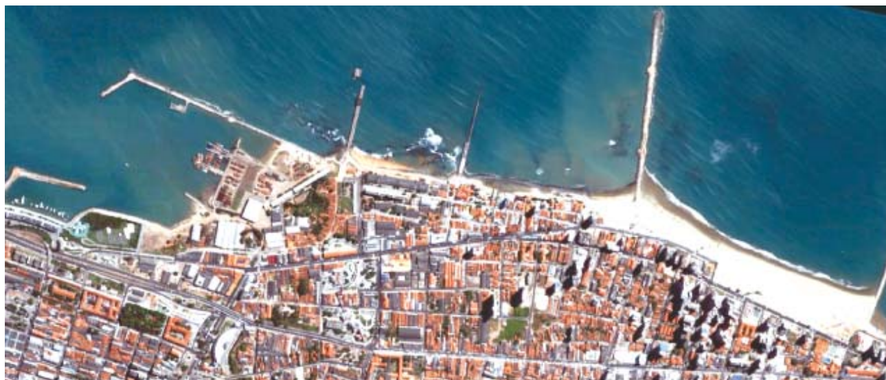
Figura 6.7 – Obras de engenharia costeira (espigões e quebra-mares) construídas ao longo do litoral de Fortaleza (CE).
